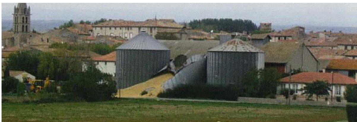
Photo 14 : Vue d'une cellule effondrée à Pezens
