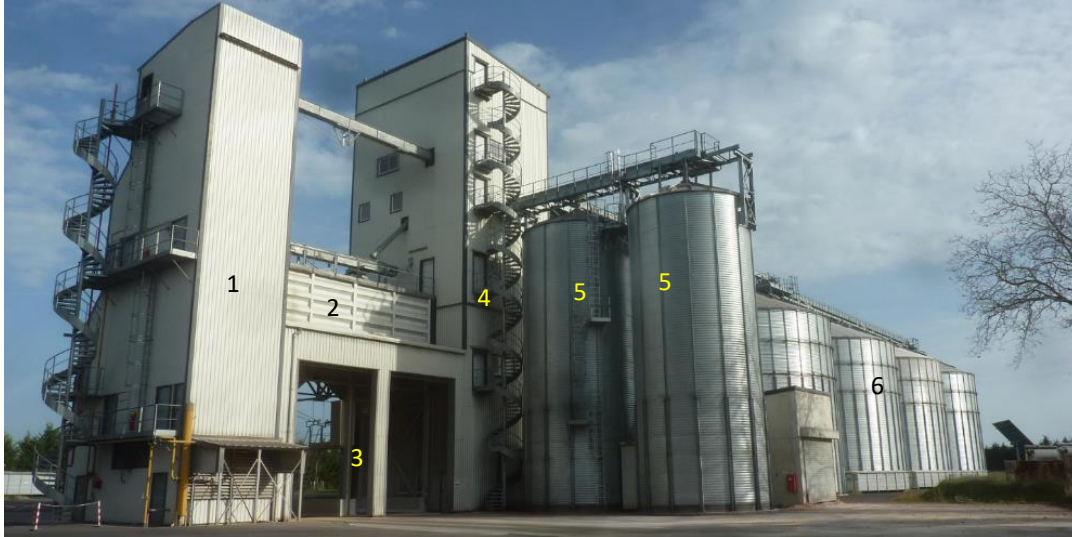
Photo 1 : vue générale du silo actuel avec le séchoir en 1, les boisseaux d'expédition en 2, les fosses de réception en 3, la tour de manutention en 4, les boisseaux grain humide en 5, le bloc cellules en 6
