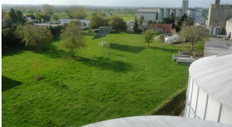
Photo 8 (ci-dessous) : vue vers l'Ouest : rue du Commerce et silos béton
