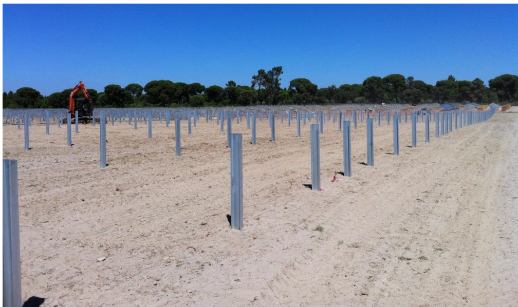
Illustration 18 : Exemple des pieux battus dans le sol, la batteuse est visible à l'arrière-plan
