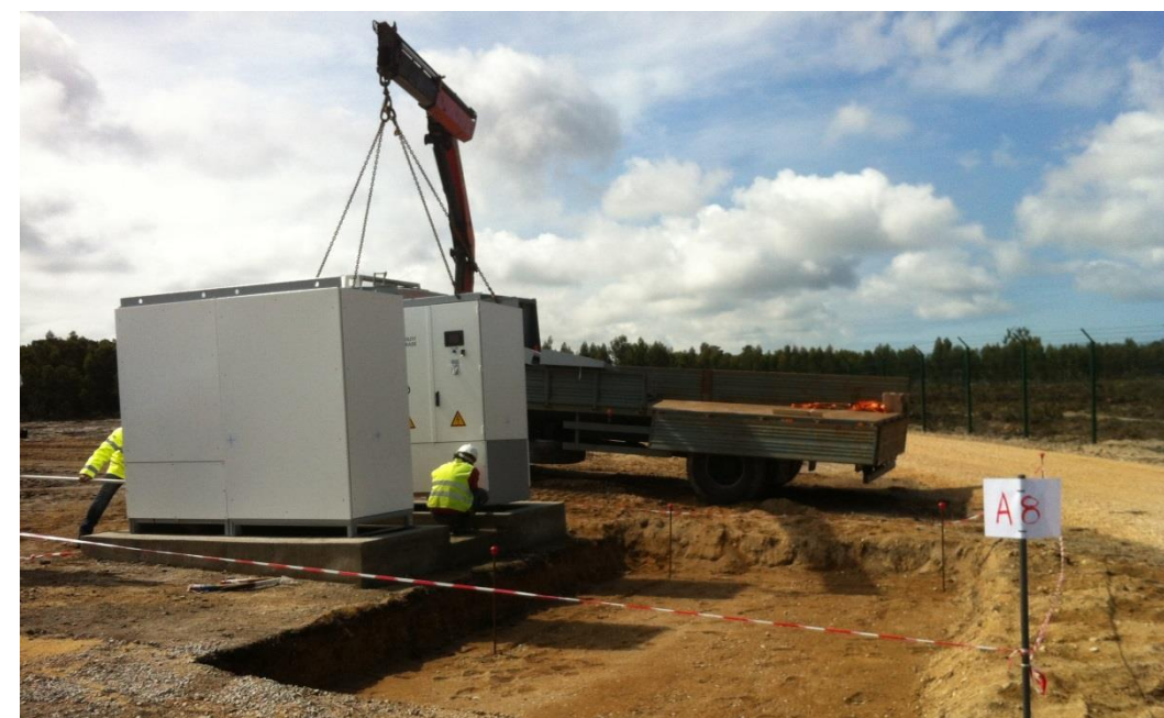
Illustration 21 : Installation des postes de conversion
