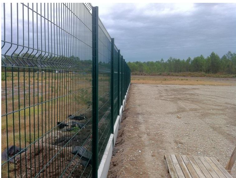
Illustration 15 : Exemple de clôture autour d'une centrale
