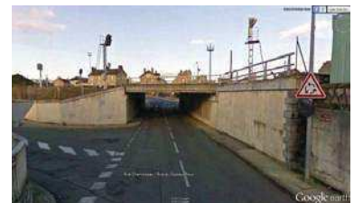
Passage inférieur rue Dr Roux (Google earth)
