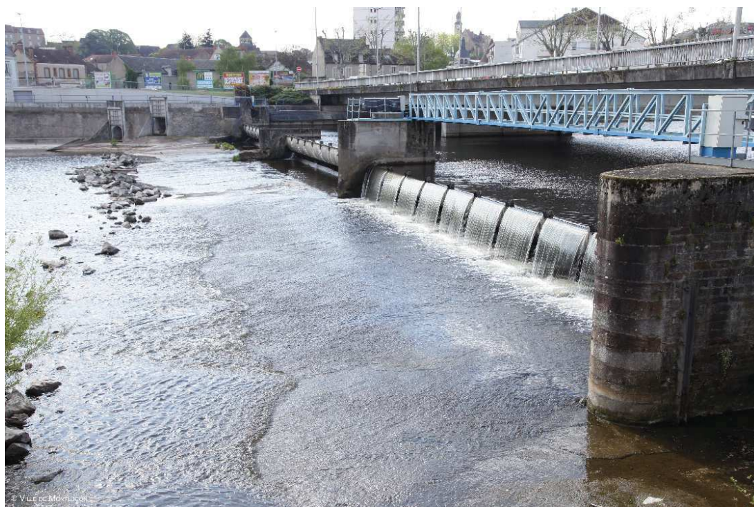
Figure 20 - Barrage mobile de Montluçon (source : Ville de Montluçon)
