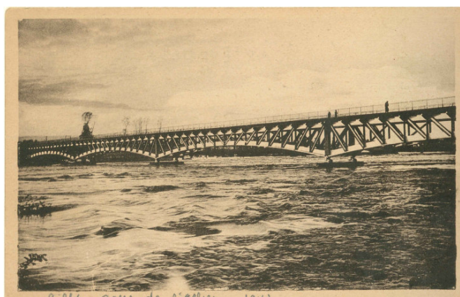
Figure 3 : Vue du pont de Billy lors de la crue de 1943
