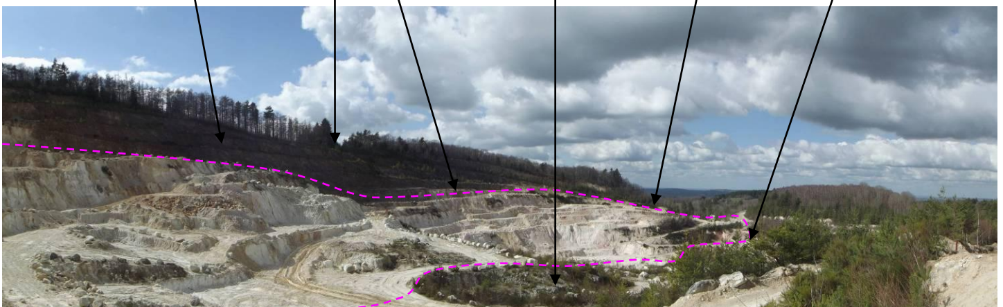
Prise de vue n° 4 illustrant l'ensemble de la zone d'extraction actuelle. Au cours de la période transitoire de 24 mois, il est prévu de poursuivre l'extraction des matériaux sur l'ensemble des niveaux déjà « actifs » de la zone d'exploitation, sans toutefois procéder à un approfondissement du carreau résiduel qui se maintiendra à sa cote altimétrique actuelle (647 m NGF). Les secteurs végétalisés, enclavés dans l'emprise de la zone d'extraction seront systématiquement préservés.
