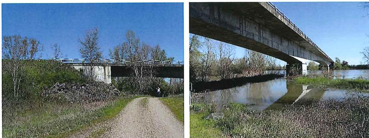
L'étude hydro-morphologique réalisée par le CEREMA en 2015 a permis de conclure à la nécessité de mise en place d'une protection de berge en pied de talus de la terrasse alluviale, compte tenu du risque d'érosion avéré sur l'ensemble de la berge en rive gauche de l'Allier, suite à la suppression des enrochements.
