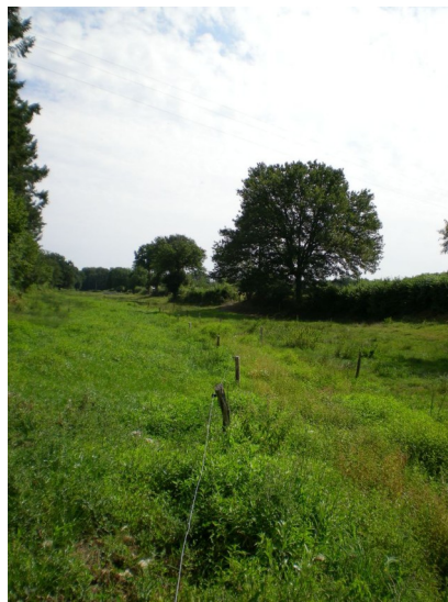
Mise en place de clôtures après travaux
