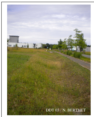
Noues d'infiltration (Bioparc – Hauterive)
