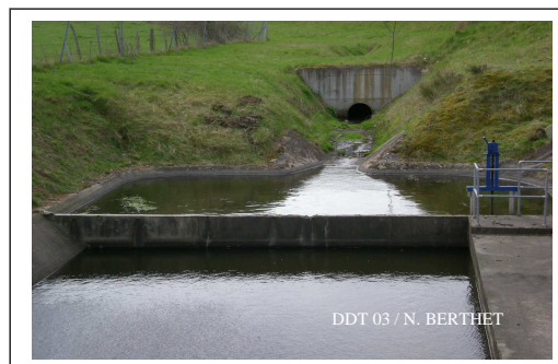
Bassin de décantation (APRR)
