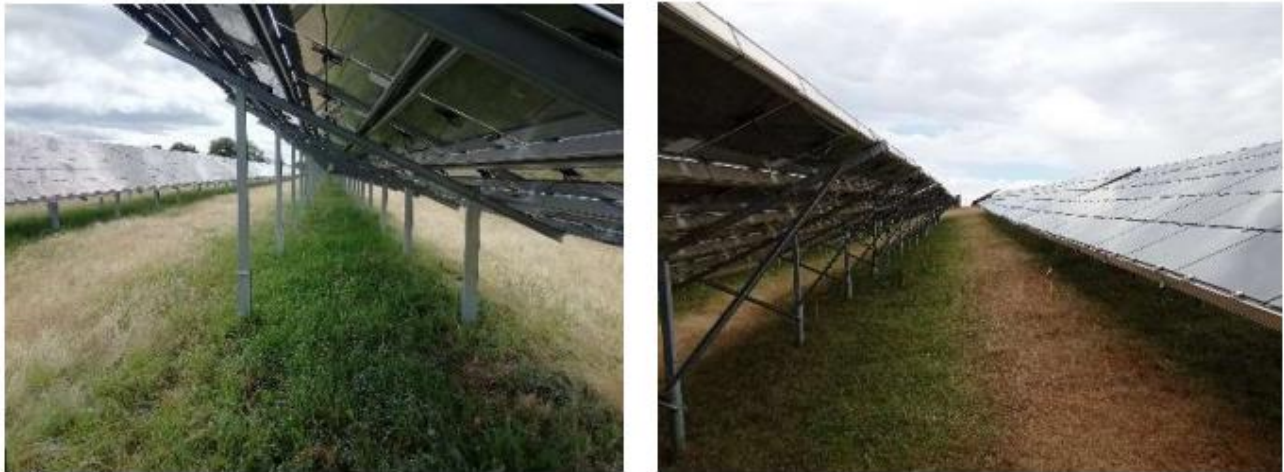
Figure 34 - Photographies sur le site de Braize dans l'Allier (gauche) et le site de Marmanhac dans le Cantal (droite) durant la période de sécheresse montrant la différence de l'état de la végétation entre l'inter-rangée et sous les panneaux (INRAe, 2022)
