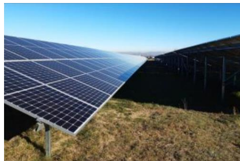
Figure 30 : Photos de panneaux fixitilt bi-pieux à gauche et de trackers 90° à droite (Source : TotalEnergies)
