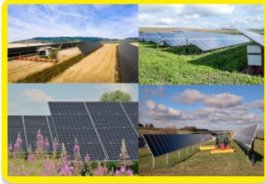
Figure 19 : Panneaux Trackers à 90° (Source : TotalEnergies)
