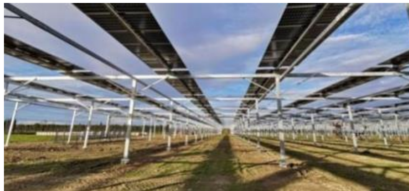
Figure 24 : Photo d'ombrières trackers dynamiques (Source : TotalEnergies)
