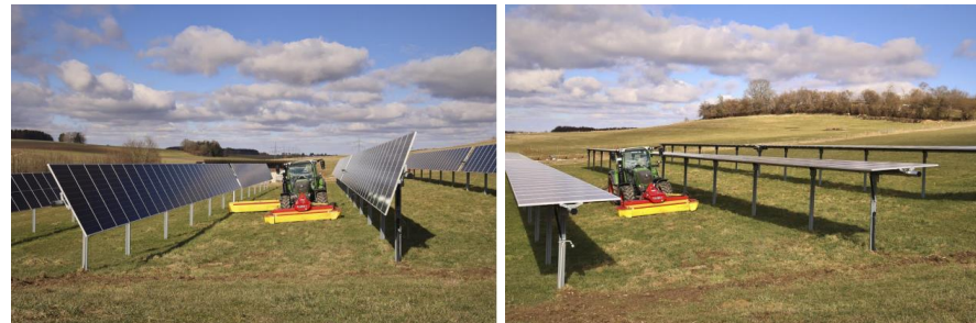
Figure 62 : Photos de panneaux trackers 90° (Source : TotalEnergies)
