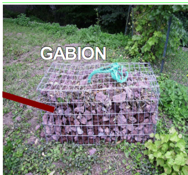
Filtre à gabions
