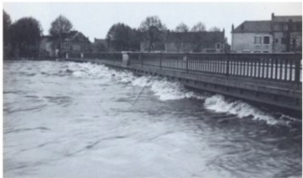
Crue de 1940 - Pont du Châtelet
