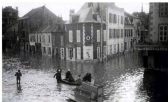
Crue du Cher à Montluçon en octobre 1960 (source:maville.com)
