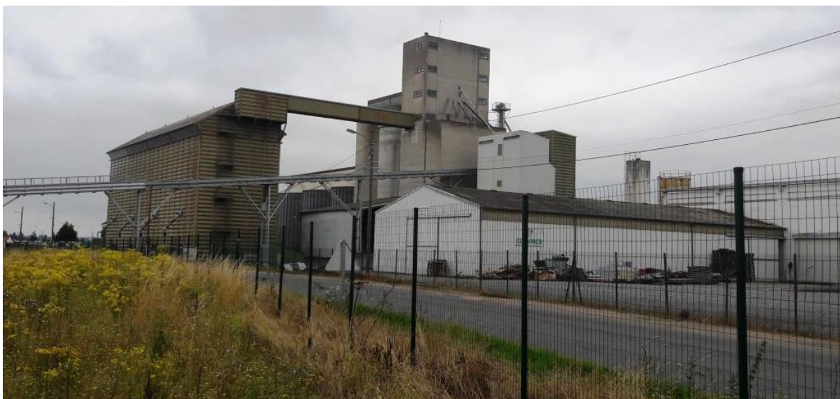
Photo 2 : vue depuis le site actuel vers l'Est : le site de COOPACA comprenant des silos
