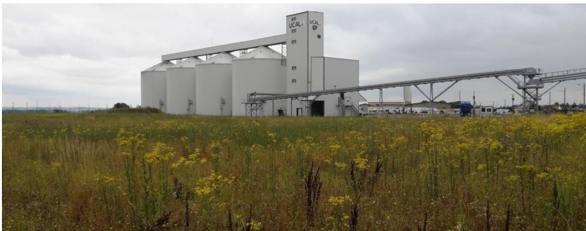
Photo 1 : vue vers le site actuel vers le Nord-Ouest : zone en herbe au premier plan, réserve foncière emplacement du projet, puis silo UCAL
