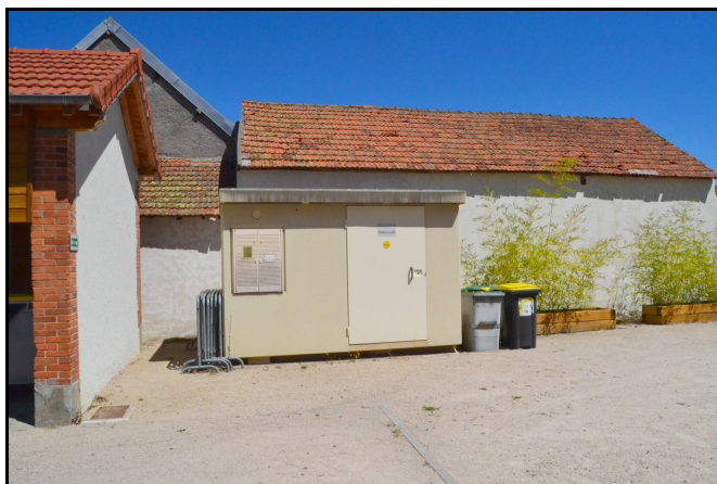
Bâtiment et constructions en bordure de l'accès à l'école primaire (au premier plan, local EDF accolé aux immeubles)
