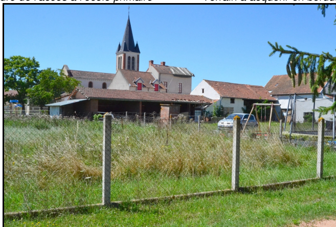
Terrain et bâtiments à acquérir vus de l'école maternelle
