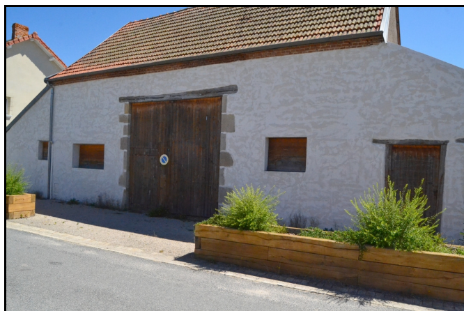
Bâtiment en bordure du chemin de l'Ancienne Église
