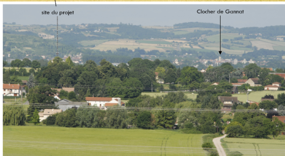
le silo sera visible au dessus des arbres mais il faut tenir compte de l'échelle des perceptions
