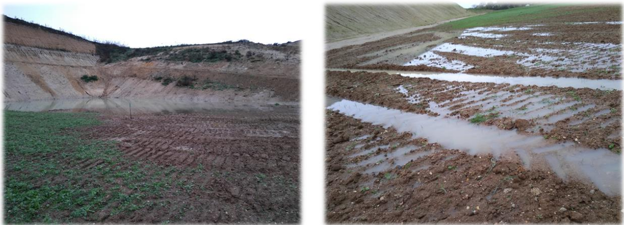
Figure 30. Photographie de la zone (Source : Prise de vue NCA)
