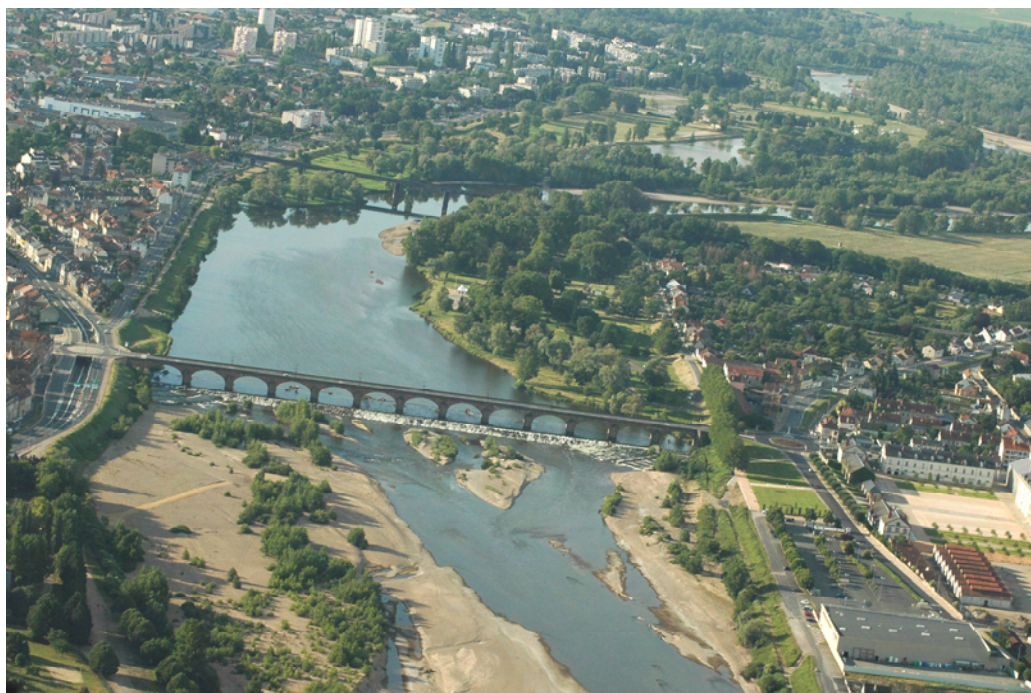
La rivière Allier au droit de la Ville de Moulins, vue de l'aval vers l'amont
